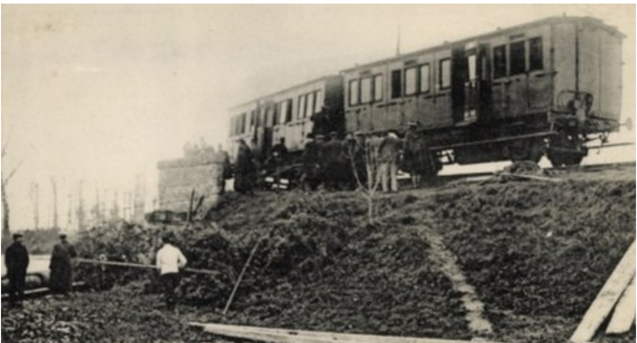
Vom Unglück verschonte Wagen vor dem Brückenwiderlager
