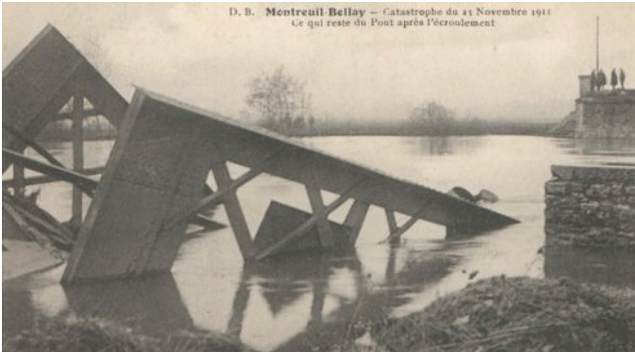
Die Überreste der Brücke nach dem Einsturz
