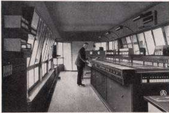
Inneren eines neuzeitlichen elektrischen Stellwerkes
