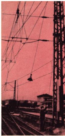
Auch bei dieser Arbeit **größte Vorsicht!** Wie Sie im Bild sehen, kann die Lampe durch Wind, schnelles Hochziehen oder hastiges Herunterlassen in Schwingungen geraten und der Oberleitung zu nahe kommen.
