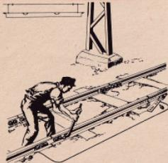
Beim **Auswechseln von Schienen** immer vorher eine ausreichend starke **Überbrückungsleitung** auslegen und ihre beiden Enden mit den liegenbleibenden Schienen durch Festklammern verbinden.
