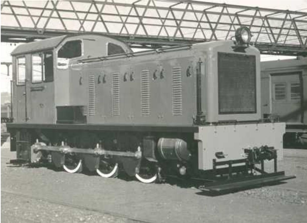
NZR Diesel **D** 0-6-0. 16 Stück 1949/1955 Vulcan Foundry/Drewry Co. 1067 mm Spurweite, + 1978-1984. Die Loks mit den Nummern 200-215 wurden 1949-1955 gebaut und zwischen 1978-1984 ausgemustert.
