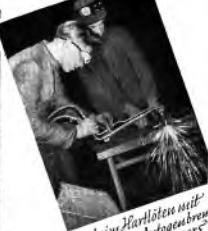
Lehrlinge beim Hartlöten mit Hilfe des Autogenbauers
