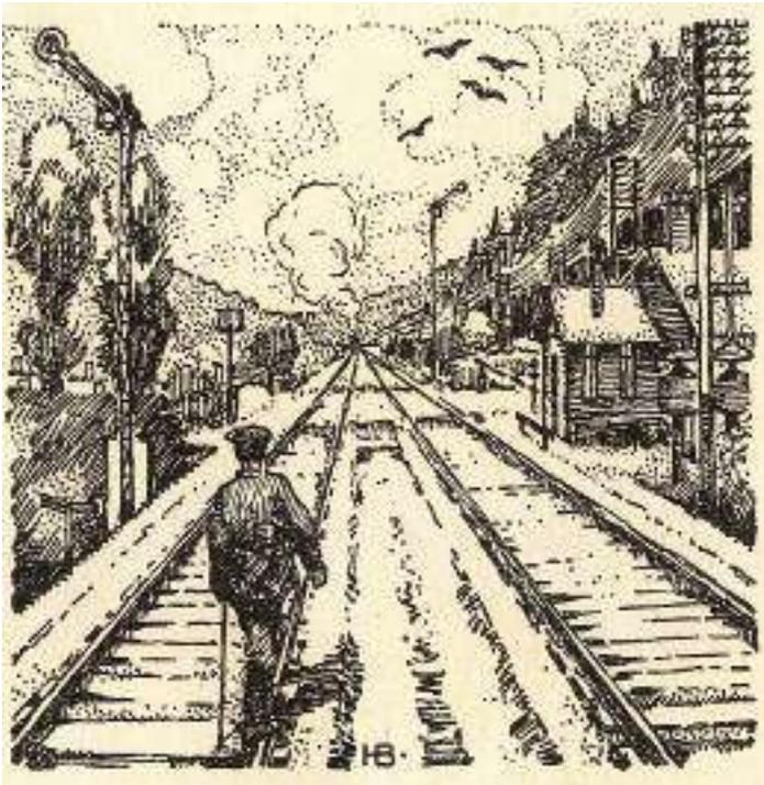
Ein Streckenläufer geht dem heranrauschenden Zug entgegen, er wird rechtzeitig das Gleis verlassen, das er mit seinem Werkzeug überprüft.
