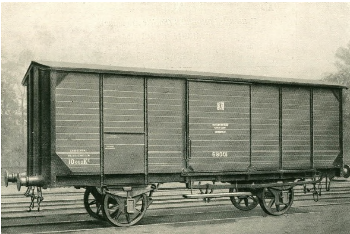
Gedeckter Güterwagen 68001 der Belgischen Staatsbahnen (Etat Belge) nach Musterblatt 121C
