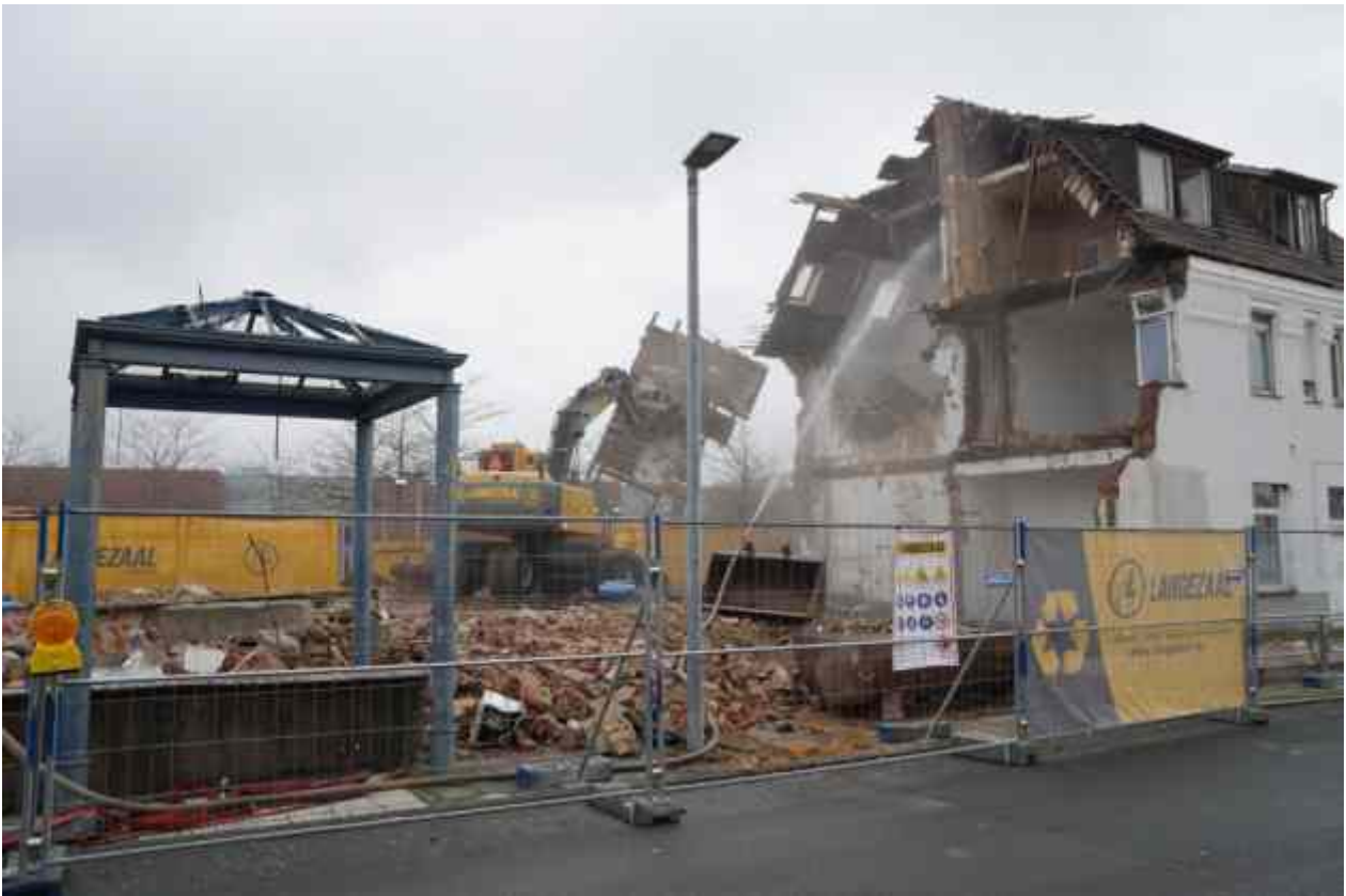
Ein Fußboden wird herausgerissen
