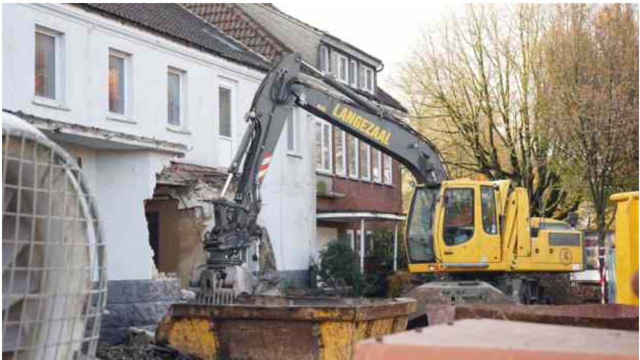
Im Kioskbereich wird das erste Loch geschlagen
