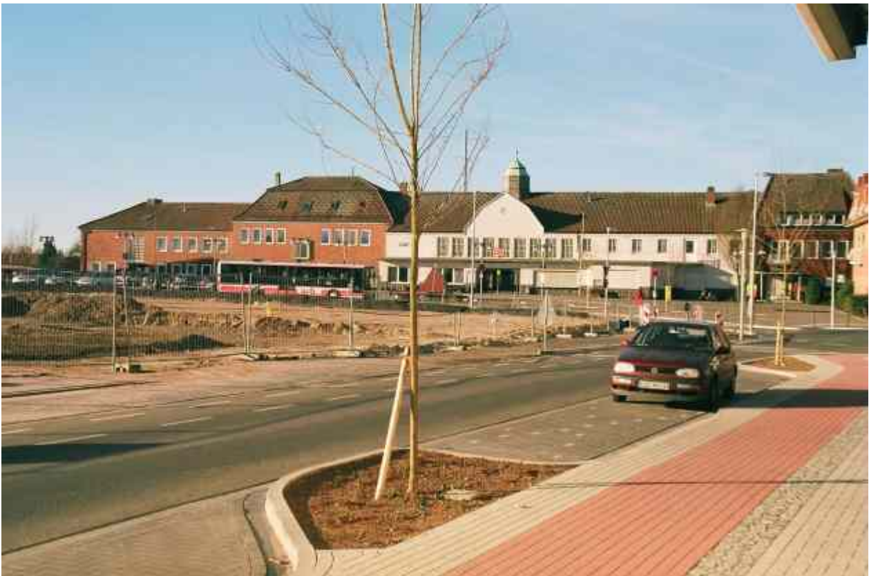
Umbaumaßnahmen rund um den Bahnhof (29.04.2008), Photo: PDH
