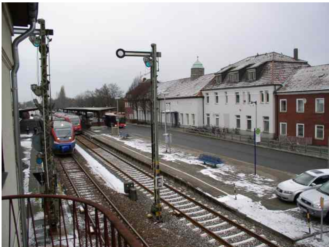
Blick vom Stellwerk Cmf auf Dieseltriebwagen, Busse und Bahnhofsgebäude (28.12.2009),
