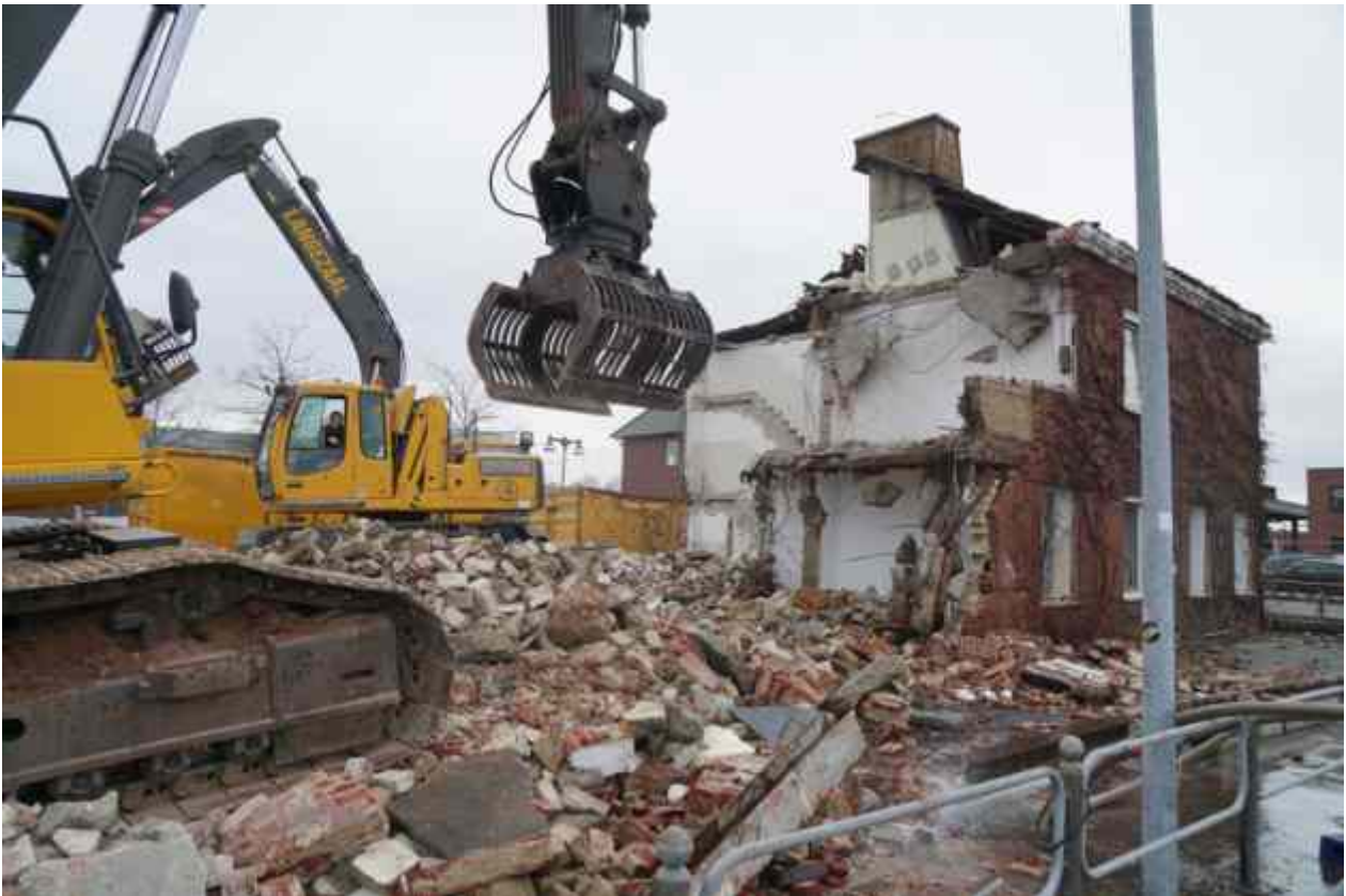
Nach dem Mittelbau werden die Seitengebäude abgerissen
