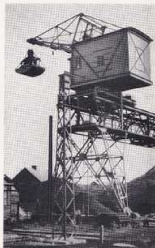
Kohlengrubeierkran für die Kieselhaus-Bekohlungsanlage
