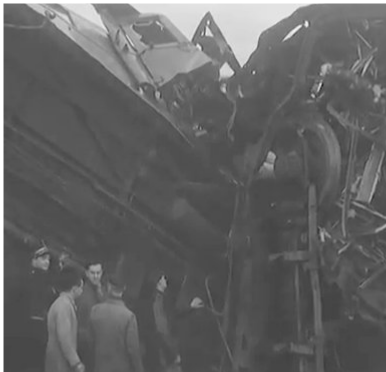
Durch die Wucht des Aufpralls hochgeschobene Trümmer des Zuges
