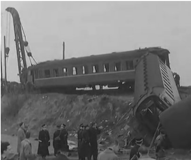
Bergungsmaßnahmen mit Kränen
