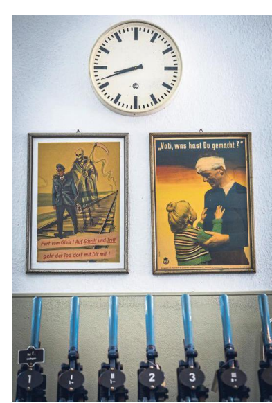
Über dem Stellwerk Unfallverhütungsbilder aus den 50er-Jahren
