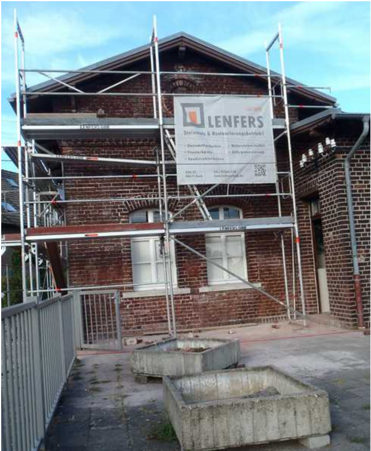
Die Pflanzen in den Betontrögen waren restlos verdorrt und harren auf Ersatz.
