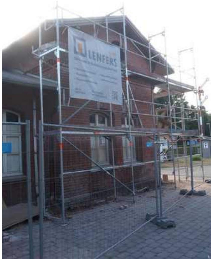
Der älteste Teil des Bahnhofsgebäudes präsentiert sich rundherum eingerüstet.
