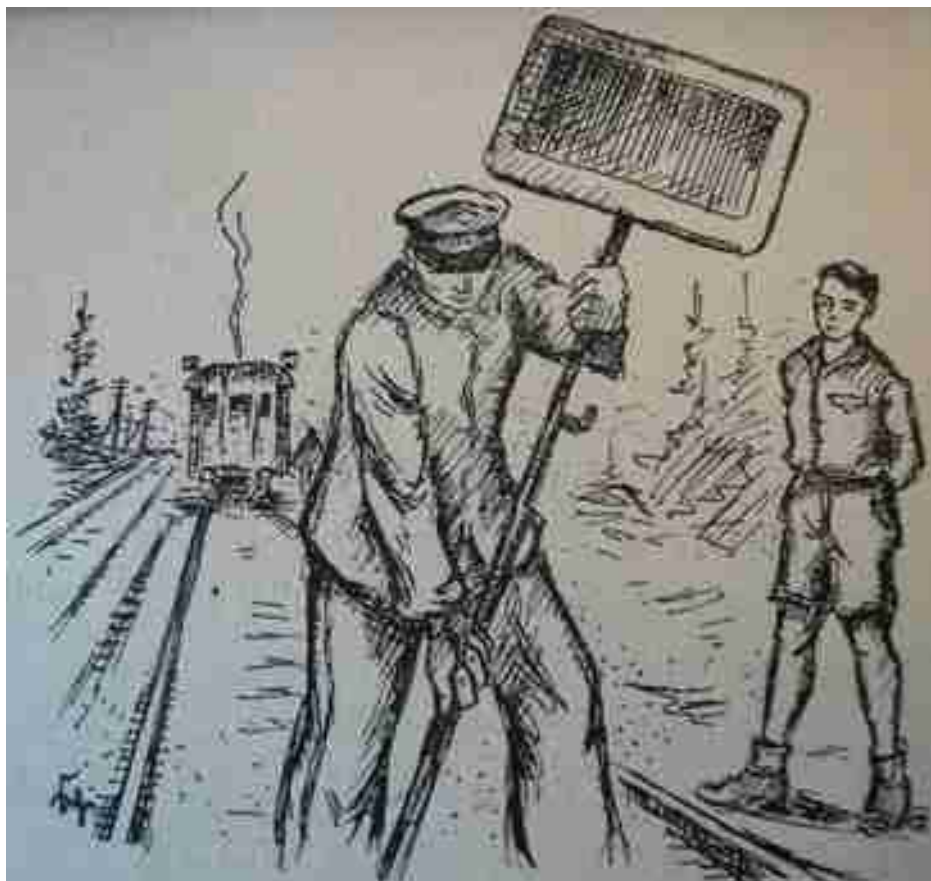
Aufstellen eines Schutzhaltesignals auf freier Strecke
