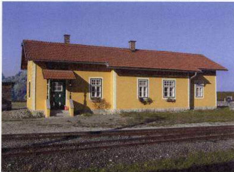
Der generalsanierte Bahnhof Aschach a. d. Steyr
