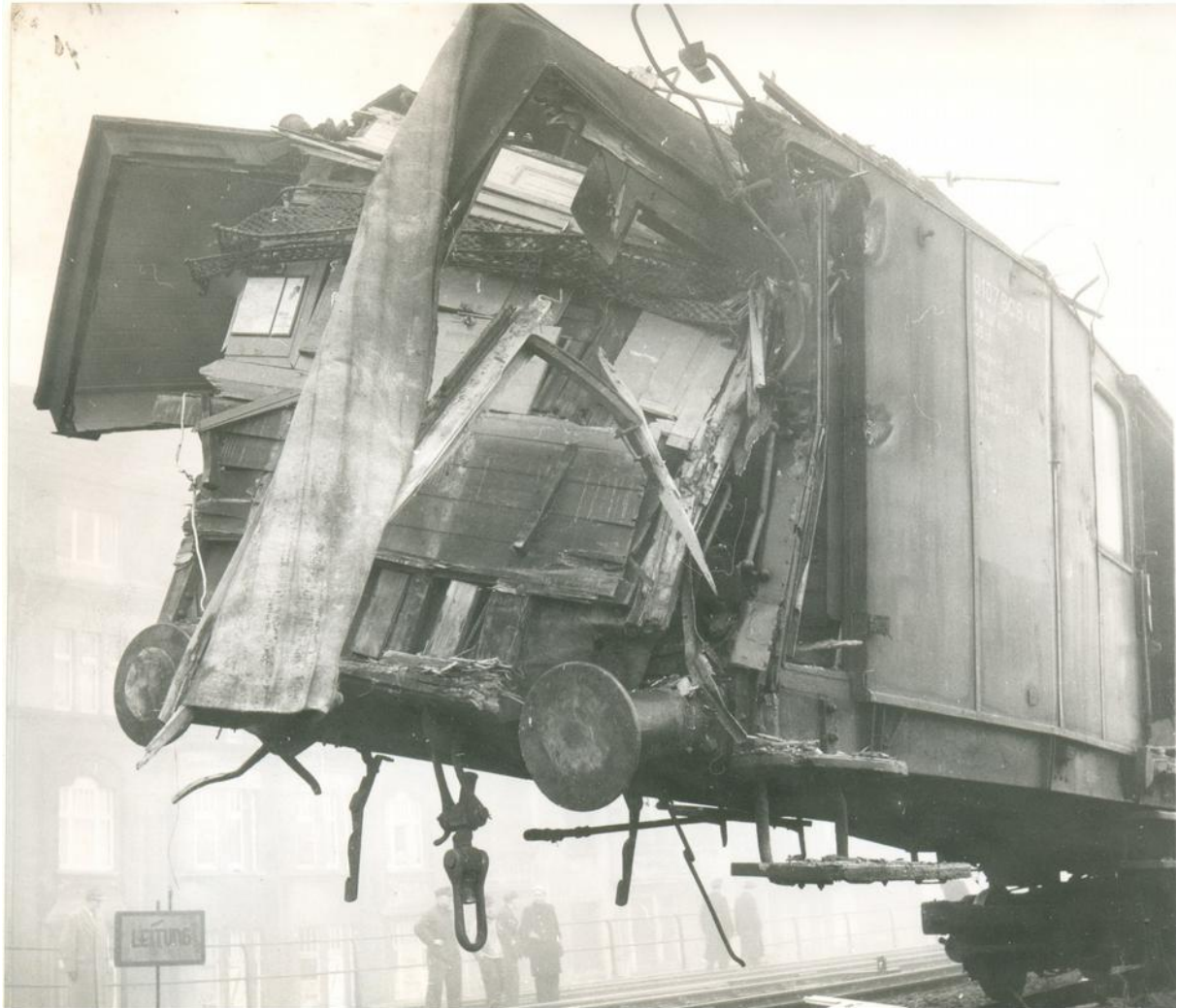
Der zerstörte Packwagen „Pw 0107 808 Köl“ zeigt die Spuren des heftigen Aufpralls.
