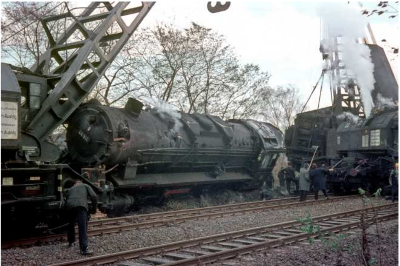
Langsam bewegte der 90 t-Kran den angehobenen Tender der 44 in Richtung Aufgleisung. Deutlich sind die Schiefelage und die Beschädigungen der Lok zu erkennen.
