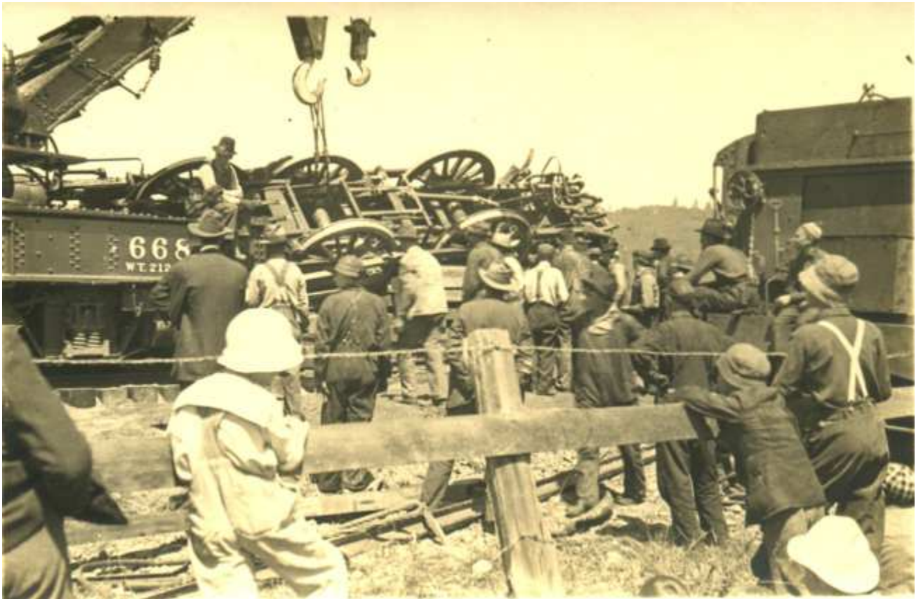
Aufräumarbeiten nach Eisenbahnunglück in den USA
