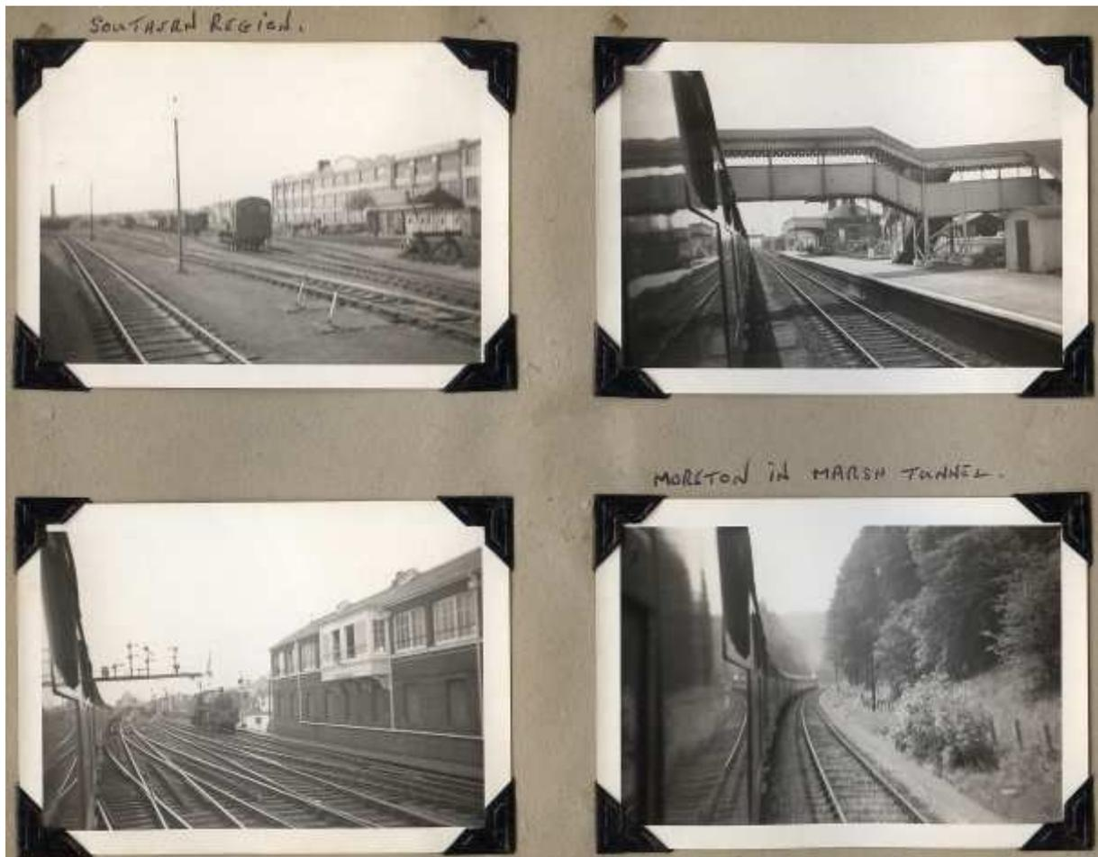
In der **Southern Region** entstanden Aufnahmen aus dem fahrenden Zug. Leicht verschwommen läßt sich eine dieselektrische Rangierlok der Baureihe 08 erkennen. Von ihr entstanden zwischen 1952 und 1962 996 Stück.
